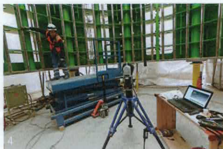
3 et 4. Montage du circuit magnétique du stator. © EDF - Christophe Huret
