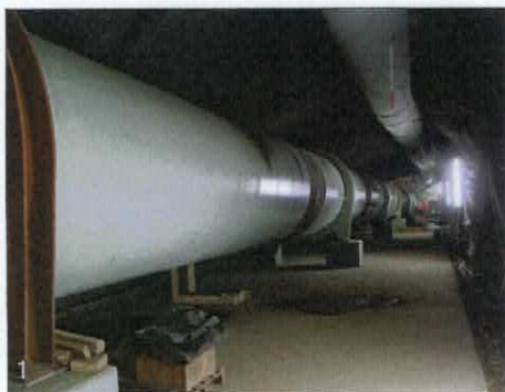
1. Mise en place des morceaux de conduite dans la galerie souterraine - 2. Soudure des éléments.
