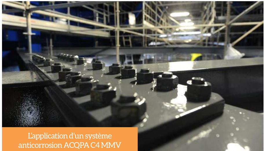
L'application d'un système anticorrosion ACQPA C4 MMV
