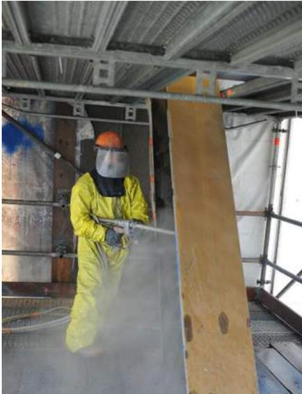
Un décapage ultra haute pression (3000 bars) et un décapage sélectif DHP1 / DHP4.
