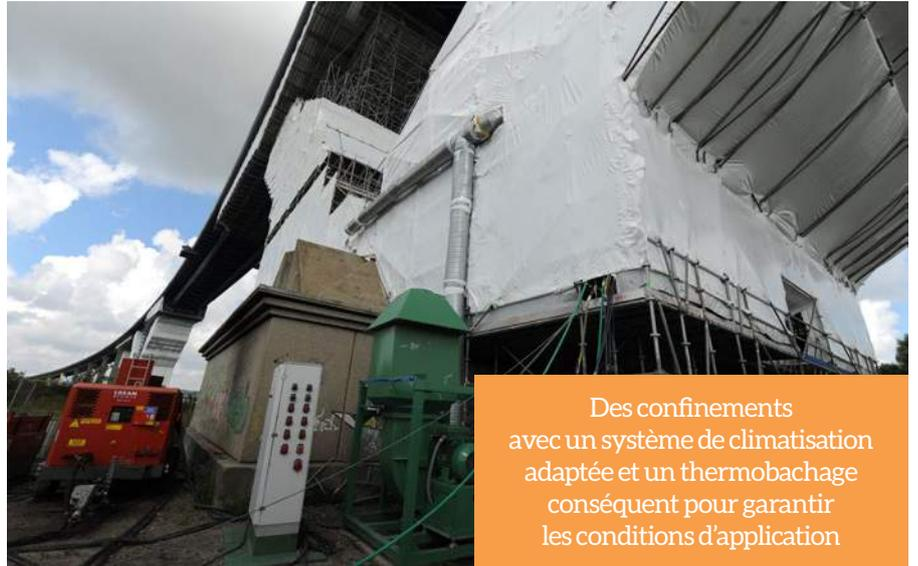
Des confinements avec un système de climatisation adaptée et un thermobachage conséquent pour garantir les conditions d'application
